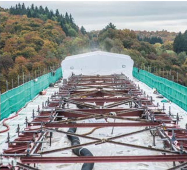
Erneuerung des zweigleisigen Oberbaus der Müngstener Brücke bei Solingen
