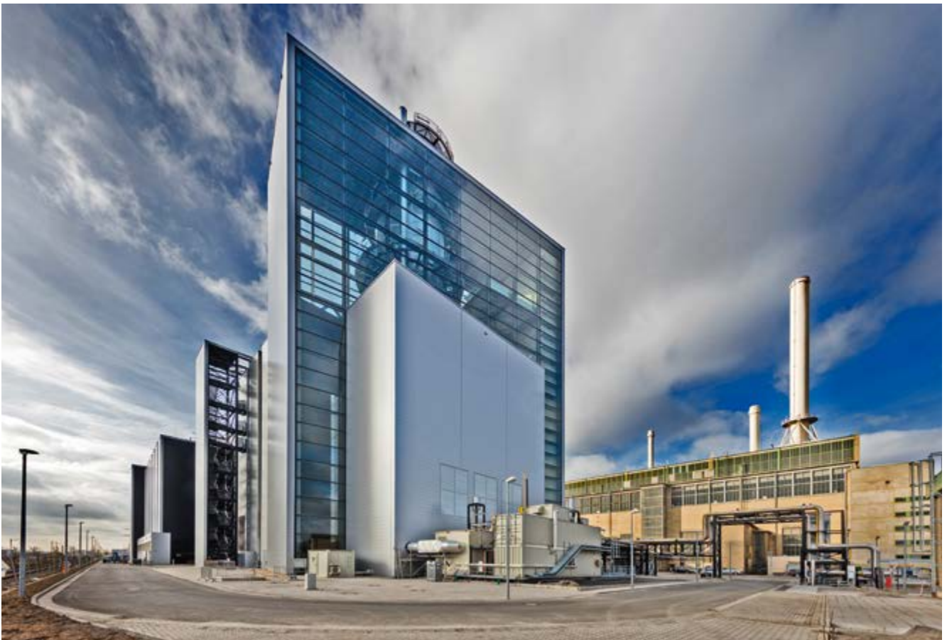
Das effizienteste Gas- und Dampfturbinen-Kraftwerk der Welt: Lausward „Fortuna“ in Düsseldorf
