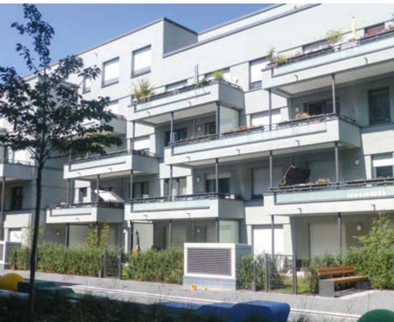
Forschungsprojekt SWD.SOL: Siedlung RKM740 in Düsseldorf-Heerdt mit einer Solarhochtemperaturanlage mit 200 m 2 Solarfläche und 108 kW Leistung für das Fernwärmenetz.
