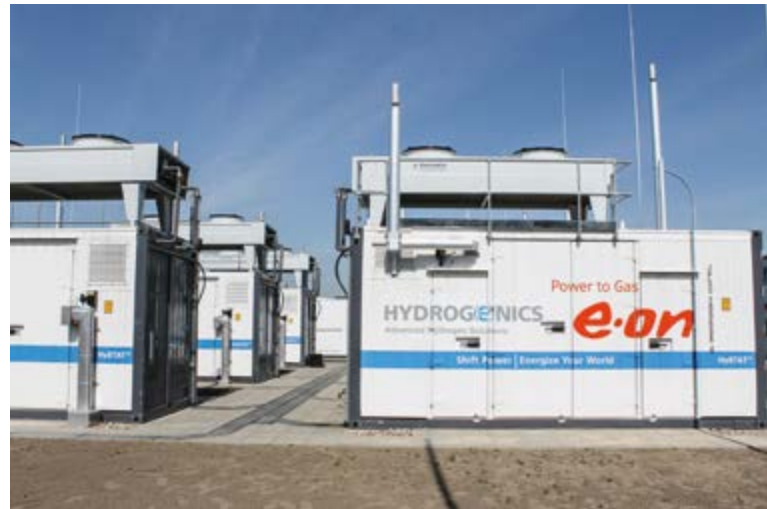
Wind als Wasserstoff speichern mit einem Elektrolyseur aus NRW: Wind-Gas-Projekt in Hamburg
