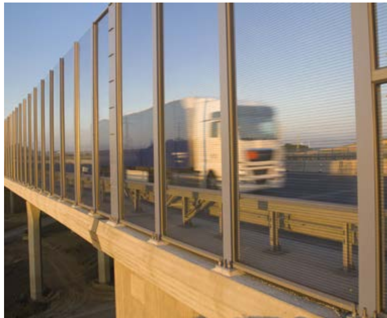
Lärmschutzmaßnahmen an Verkehrswegen
