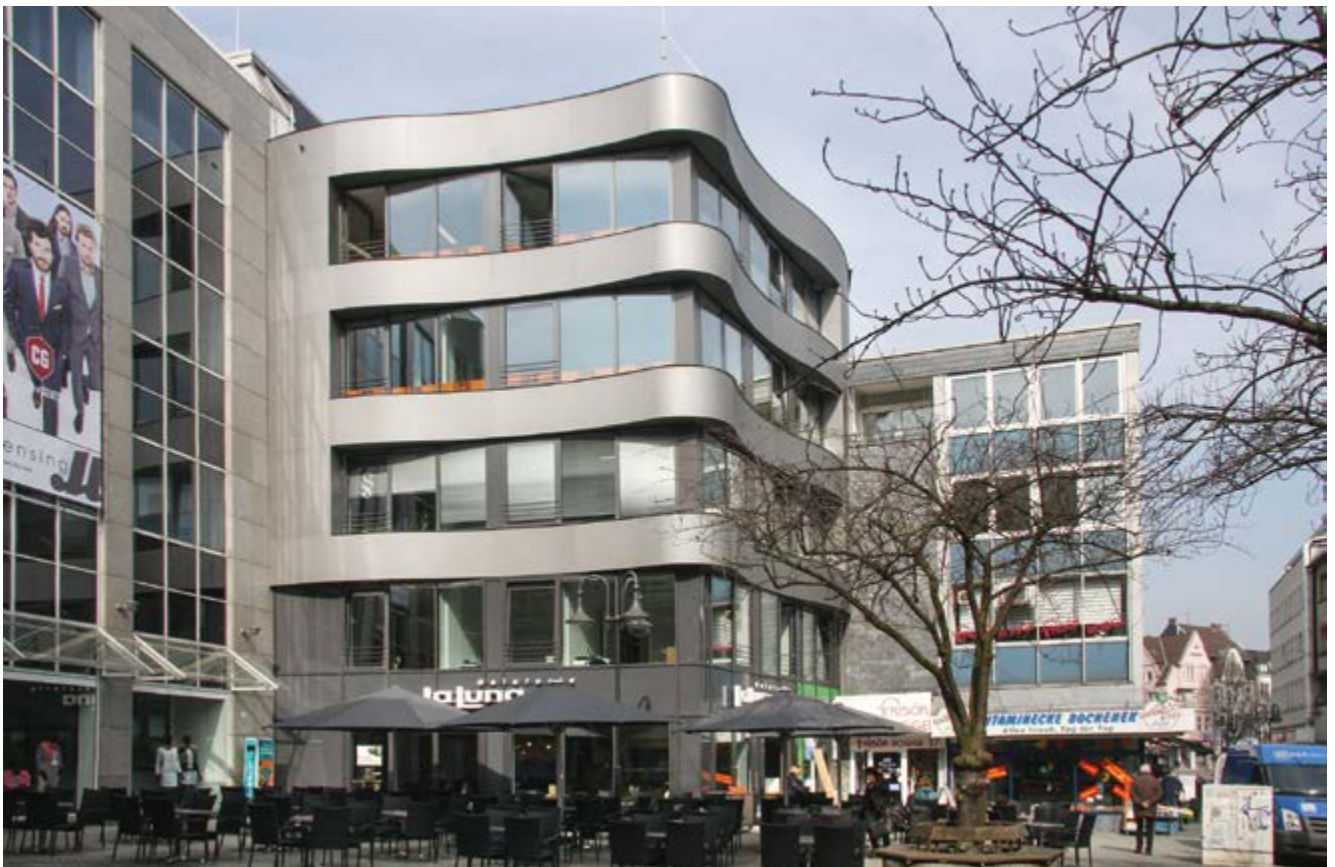
Plus-Energie-Haus: im Rahmen der InnovationCity Ruhr modernisierte Gewerbeimmobilie in Bottrop
