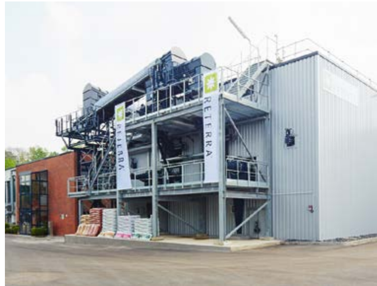
Bei Vergärung von Bioabfällen gewonnenes Biogas wird in Coesfeld direkt in das Erdgasnetz eingespeist.
