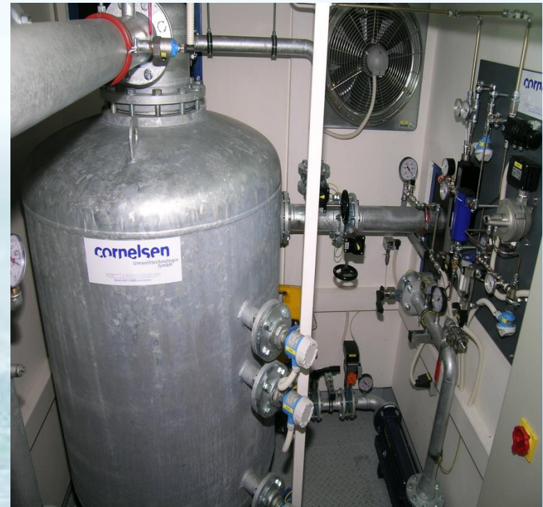
Blick in eine HVE-Anlage
