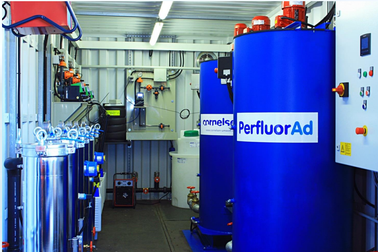
Mobile PerfluorAd-Löschwasserreinigungsanlage (eingebaut in 20" Container)
