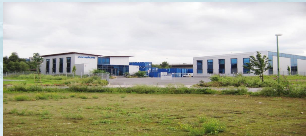
Bürogebäude und Fertigungswerkstatt
