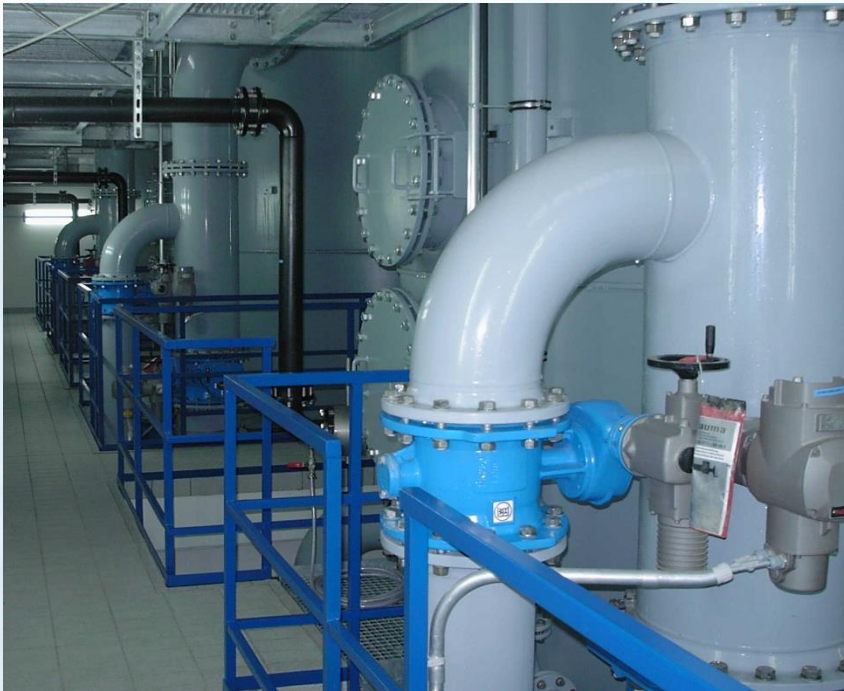
Filterkessel mit Verrohrung
