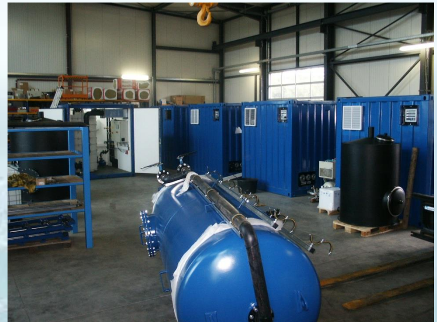
Blick in die Werk- und Montagehalle
